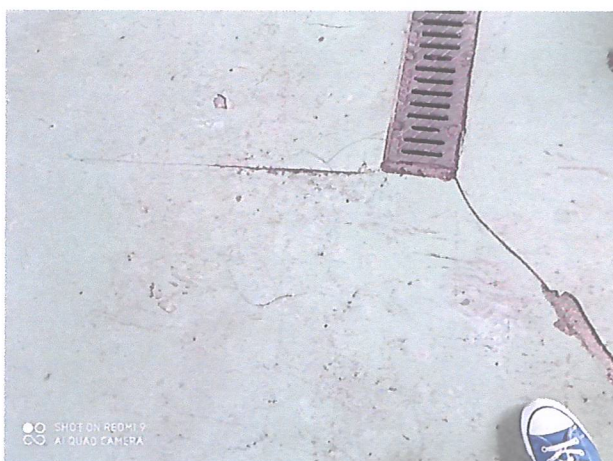
Zdj. nr 11 Dylatacja i zniszczona posadzka
